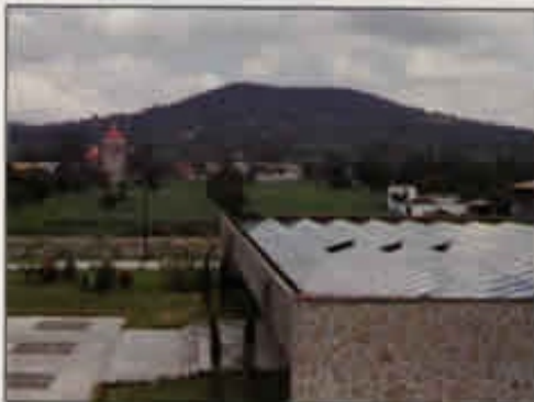
Alberca semi olímpica en Tlaxcala, México. 310 Paneles.
