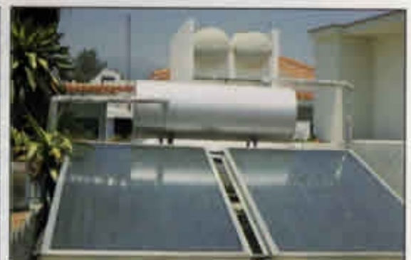
Uso Residencial, México, D.F. 2 Paneles, termo-tanque de 250 lts. y válvula anti-congelante.
